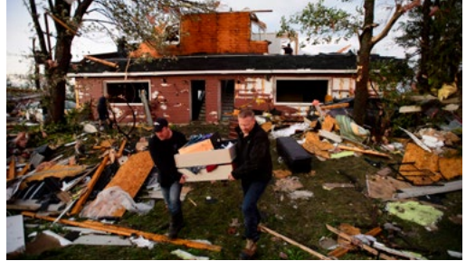
FIGURE 1 : Dommages causés par une tornade à Dunrobin, Ontario (22 septembre 2018)
